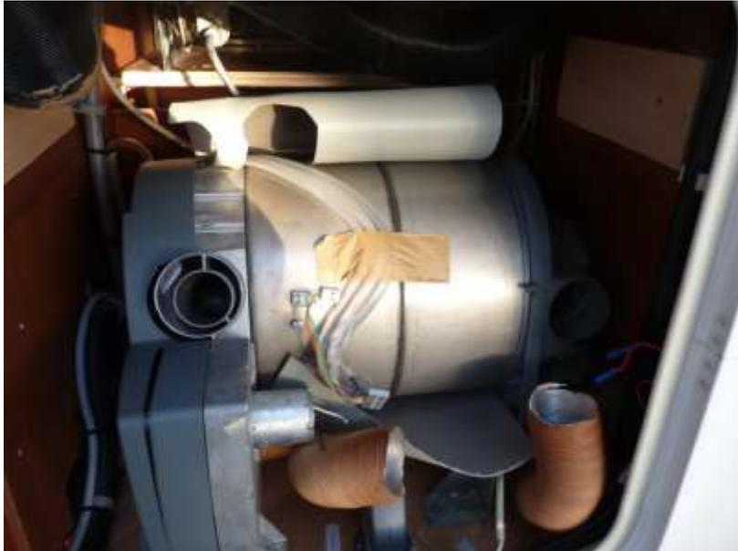
Voilà, je vais pouvoir poser ma résistance, ainsi que la sonde de température. ( J'ai du couper les 2 fils du moteur de ventilation, la prise ne voulant pas venir )
