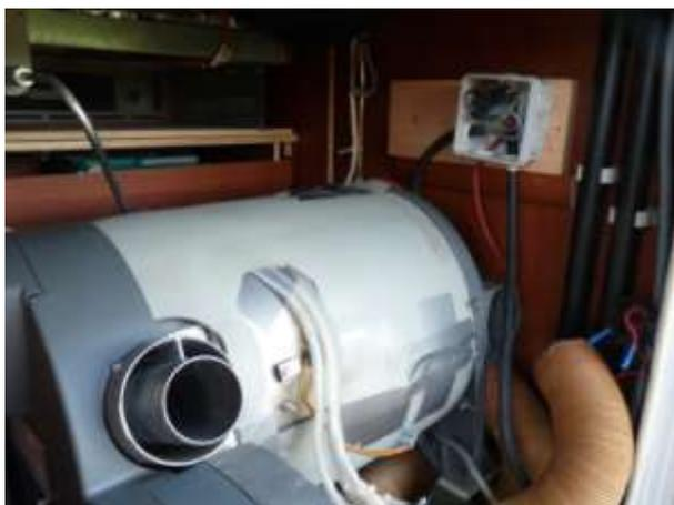
Maintenant, il faut faire le circuit électrique, vers le régulateur de température. J'ai installé sur le régulateur à coté de la porte d'entrée, non loin du tableau de commande. Cela demande un peu de réflexion pour le passage des câbles. Ne pas oublier de mettre une protection de surtension
